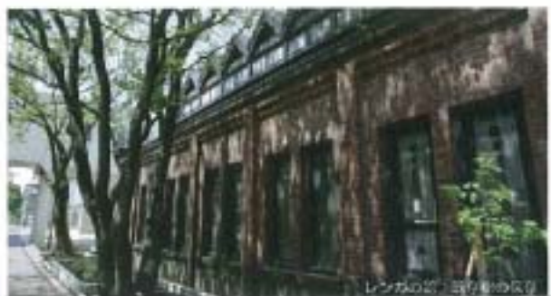
レンガの館：通り抜けの入り
